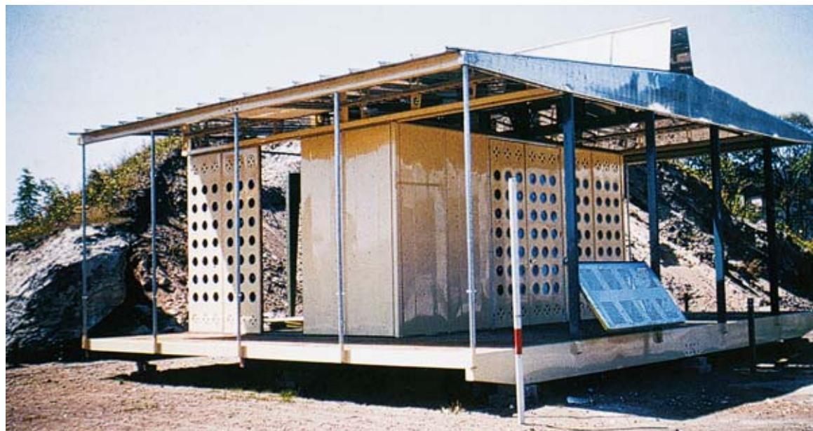
Montage d'une partie de la Maison Tropicale de Brazzaville, Nancy, 1951. © Centre Georges Pompidou, Paris
